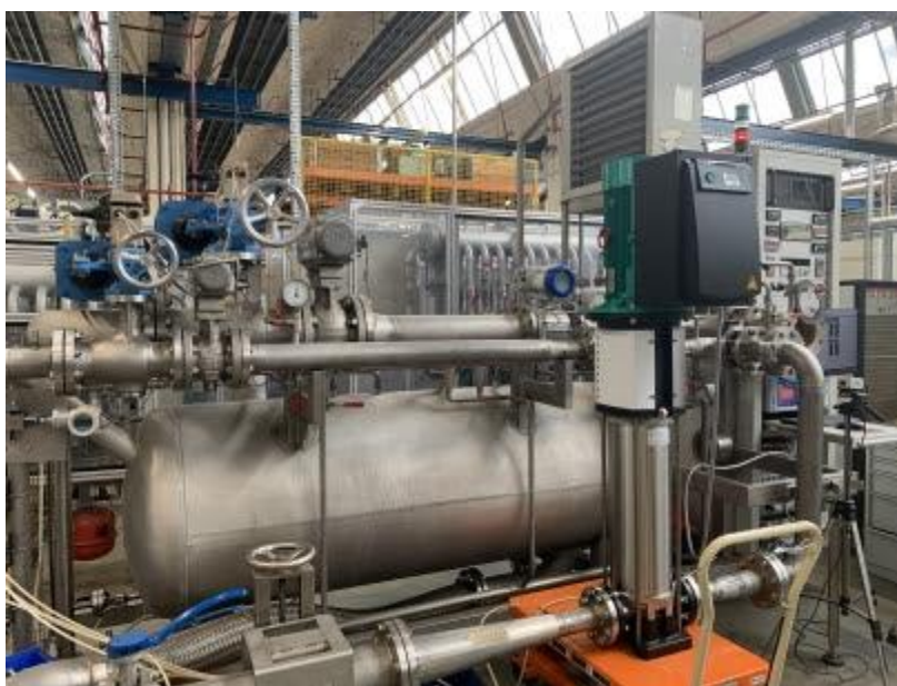
Banc d'essai du laboratoire R&D du site Wilo France à Laval.
