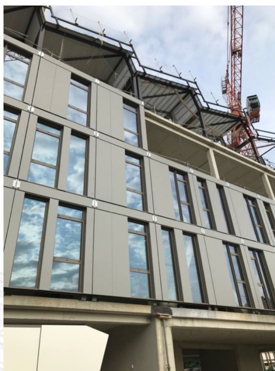
Châssis cadres WICLINE 65 en cours d'installation par Lenoir Métallerie sur le bâtiment S-One à Lyon.
