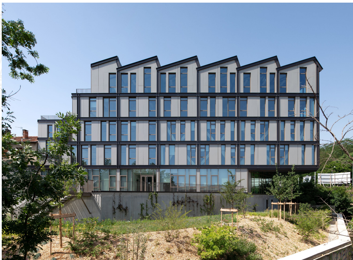
S-One à Lyon. Architecte SOHO ATLAS IN FINE Image © Erick Sallet
