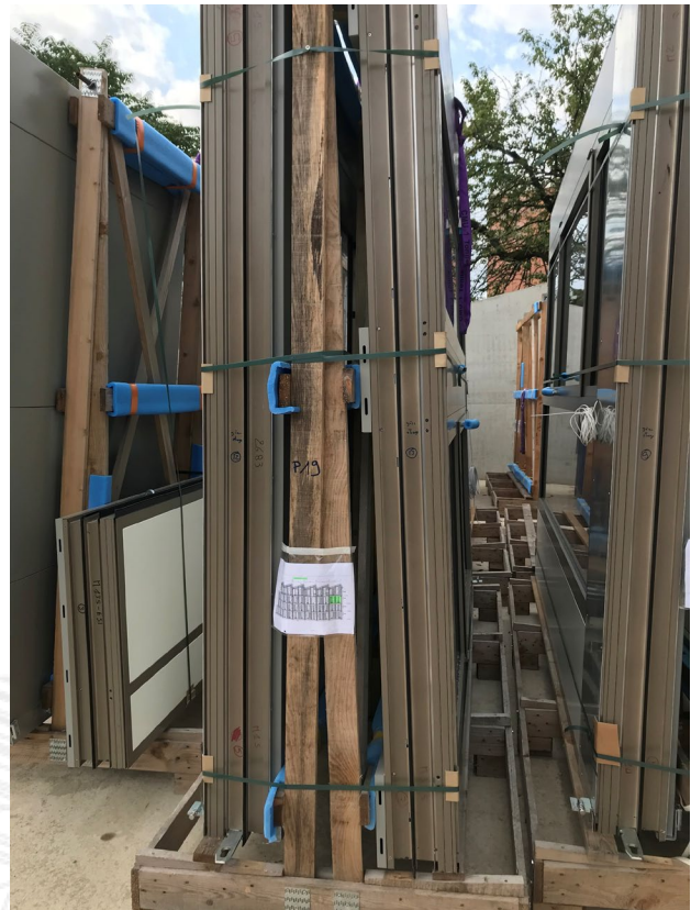
Stockage des châssis cadres pour le bâtiment S-One à Lyon. Architecte SOHO ATLAS IN FINE © WICONA Image © WICONA
