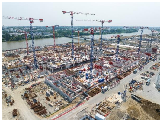
Chantier CHU, Nantes - Crédit photo : Julien Gazeau
