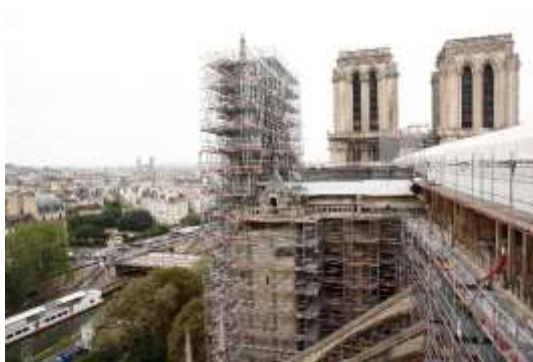
Visuel 1 Les transepts de la cathédrale sont surmontés de deux nouveaux échafaudages. Ils sont destinés à la restauration des pignons nord et sud, fortement endommagés par les flammes et consolidés dès les jours qui ont suivi l'incendie. © David Bordes / Etablissement public chargé de la conservation et de la restauration de la cathédrale Notre-Dame de Paris
