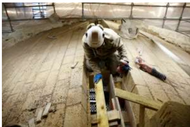
Visuel 5 A l'aide de cintres placés sous les arcs, les maçons tailleurs de pierre repositionnent les claveaux, des blocs de pierre taillés en biseau, constituant l'arc et joints par du mortier. © David Bordes - Etablissement public chargé de la conservation et de la restauration de la cathédrale Notre-Dame de Paris
