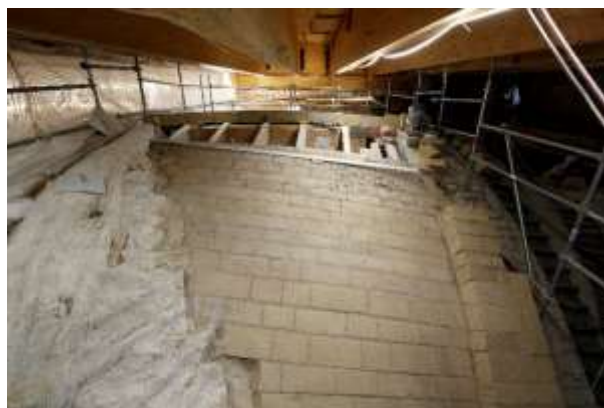
Visuel 2 Fermeture de la première des voûtes effondrées par les maçons tailleurs de pierre, sur le transept nord. © David Bordes - Etablissement public chargé de la conservation et de la restauration de la cathédrale Notre-Dame de Paris
