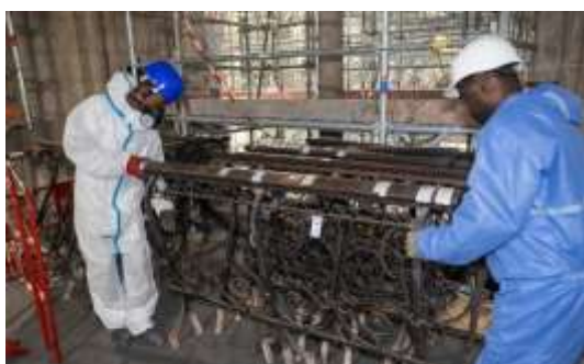
Visuel 3 Dépose des garde-corps. © Patrick Zachmann – Magnum Photos – Utilisation soumise à conditions
