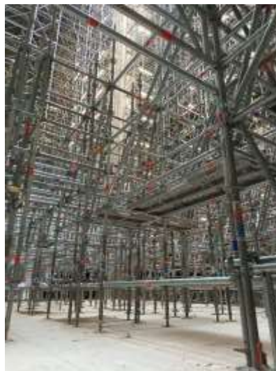
Visuel 11 Pose des premiers éléments de l'échafaudage nécessaire à la reconstruction de la flèche. © Albane Gauvain / Etablissement public chargé de la conservation et de la restauration de la cathédrale Notre-Dame de Paris
