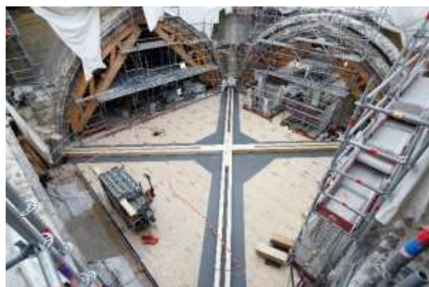
Visuel 15 Après plusieurs semaines de montage, le premier plancher, à hauteur des voûtes a été livré. Ce premier niveau permettra d'accueillir les cintres qui serviront à reconstruire les arcs de la voûte de la croisée du transept. © David Bordes - Etablissement public chargé de la conservation et de la restauration de la cathédrale Notre-Dame de Paris
