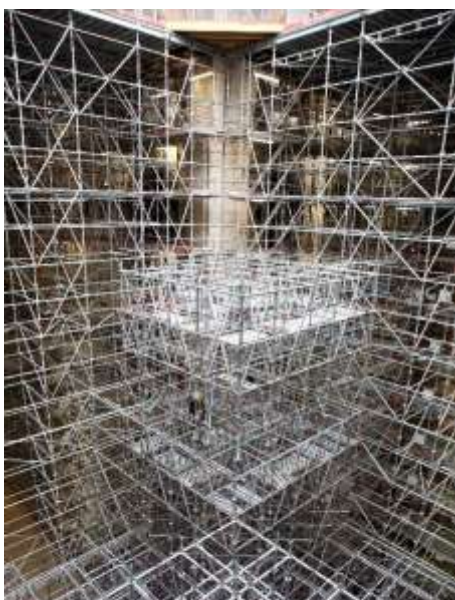
Visuel 12 Montage de l'échafaudage nécessaire à la reconstruction de la flèche. © David Bordes / Etablissement public chargé de la conservation et de la restauration de la cathédrale Notre-Dame de Paris
