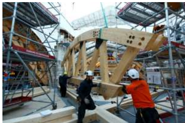
Visuel 19 Pose des cintres qui serviront à reconstruire les arcs de la voûte à la croisée du transept. © David Bordes - Etablissement public chargé de la conservation et de la restauration de la cathédrale Notre-Dame de Paris
