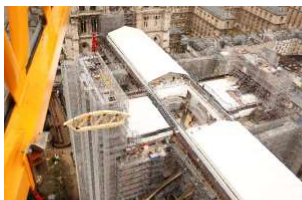
Visuel 17 Grutage des cintres qui serviront à reconstruire les arcs de la voûte à la croisée du transept. © David Bordes - Etablissement public chargé de la conservation et de la restauration de la cathédrale Notre-Dame de Paris
