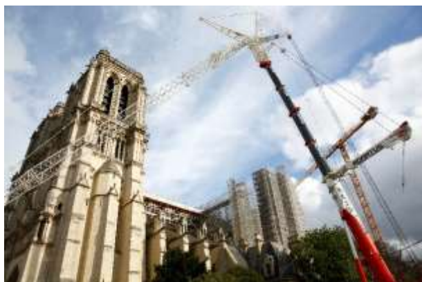
Visuel 5 Vue sud de la cathédrale et de la nouvelle grue mobile de 350 tonnes installée sur le chantier. Elle assure le levage d'éléments d'échafaudages et de matériels nécessaires aux travaux de restauration des maçonneries du pignon sud et du bras sud du transept puis des éléments de charpente et de couverture de la nef. © David Bordes / Etablissement public chargé de la conservation et de la restauration de la cathédrale Notre-Dame de Paris
