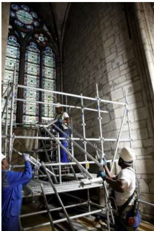
Visuel 1 Montage des échafaudages dans les chapelles, étape préalable à leur restauration. © David Bordes / Etablissement public chargé de la conservation et de la restauration de la cathédrale Notre-Dame de Paris
