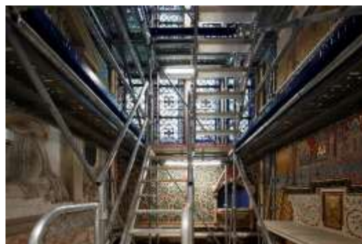
Visuel 2 Montage des échafaudages dans les chapelles, étape préalable à la restauration des peintures murales. © David Bordes / Etablissement public chargé de la conservation et de la restauration de la cathédrale Notre-Dame de Paris
