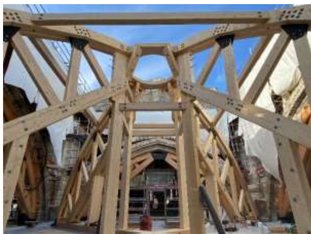
Visuel 23 Les cintres qui serviront à reconstruire les arcs de la voûte à la croisée du transept sont posés. © Etablissement public chargé de la conservation et de la restauration de la cathédrale Notre-Dame de Paris
