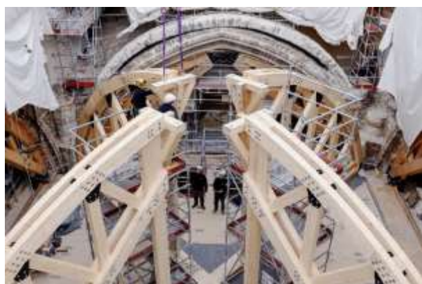
Visuel 20 Pose des cintres qui serviront à reconstruire les arcs de la voûte à la croisée du transept. © Patrick Zachmann – Magnum Photos – Utilisation soumise à conditions
