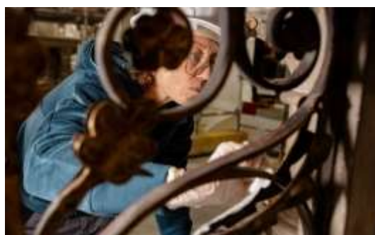
Visuel 4 Les garde-corps sont déposés pour être restaurés en atelier. © Patrick Zachmann – Magnum Photos – Utilisation soumise à conditions
