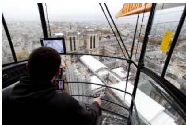
Visuel 16 Grutage des cintres qui serviront à reconstruire les arcs de la voûte à la croisée du transept. © David Bordes - Etablissement public chargé de la conservation et de la restauration de la cathédrale Notre-Dame de Paris
