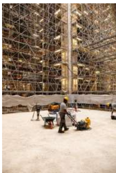
Visuel 3 Le sol à la croisée du transept en train d'être comblé par de la grave compactée. © David Bordes / Etablissement public chargé de la conservation et de la restauration de la cathédrale Notre-Dame de Paris
