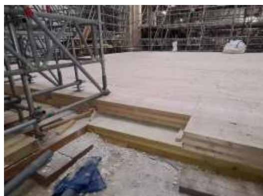
Visuel 9 Fin de la pose de La raquette en bois, plancher de répartition des charges sur lequel prendra appui l'échafaudage nécessaire à la reconstruction de la flèche. © Etablissement public chargé de la conservation et de la restauration de la cathédrale Notre-Dame de Paris
