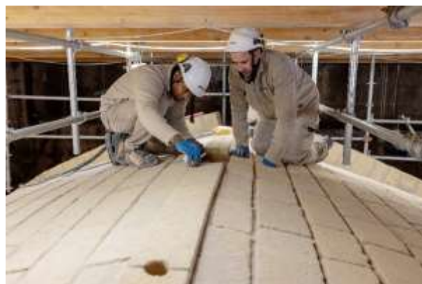
Visuel 6 A l'aide de cintres placés sous les arcs, les maçons tailleurs de pierre repositionnent les claveaux, des blocs de pierre taillés en biseau, constituant l'arc et joints par du mortier. © Patrick Zachmann – Magnum Photos – Utilisation soumise à conditions
