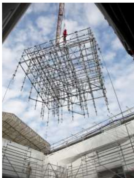
Visuel 13 Grutage des éléments de l'échafaudage nécessaire à la reconstruction de la flèche. © David Bordes / Etablissement public chargé de la conservation et de la restauration de la cathédrale Notre-Dame de Paris
