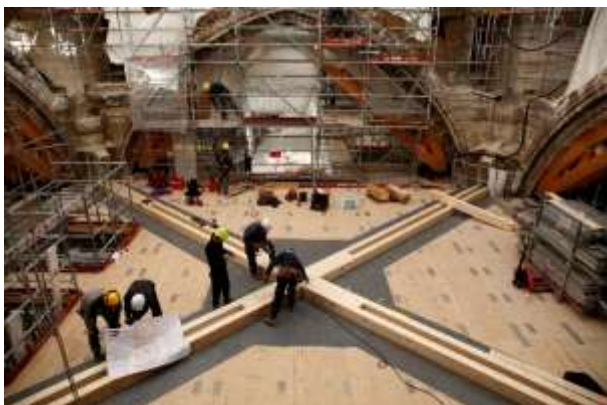
Visuel 14 Après plusieurs semaines de montage, le premier plancher, à hauteur des voûtes a été livré. Ce premier niveau permettra d'accueillir les cintres qui serviront à reconstruire les arcs de la voûte de la croisée du transept. © David Bordes - Etablissement public chargé de la conservation et de la restauration de la cathédrale Notre-Dame de Paris
