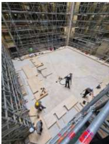
Visuel 5 Pose des premiers éléments de la raquette en bois, plancher de répartition des charges sur lequel prendra appui l'échafaudage nécessaire à la reconstruction de la flèche. © Etablissement public chargé de la conservation et de la restauration de la cathédrale Notre-Dame de Paris
