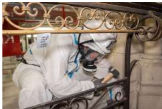
Visuel 2 Dépose des garde-corps. © Patrick Zachmann – Magnum Photos – Utilisation soumise à conditions
