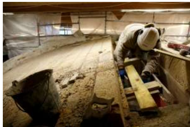
Visuel 4 A l'aide de cintres placés sous les arcs, les maçons tailleurs de pierre repositionnent les claveaux, des blocs de pierre taillés en biseau, constituant l'arc et joints par du mortier. © David Bordes - Etablissement public chargé de la conservation et de la restauration de la cathédrale Notre-Dame de Paris
