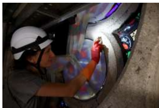
Visuel 2 Nettoyage des maçonneries. © David Bordes / Etablissement public chargé de la conservation et de la restauration de la cathédrale Notre-Dame de Paris
