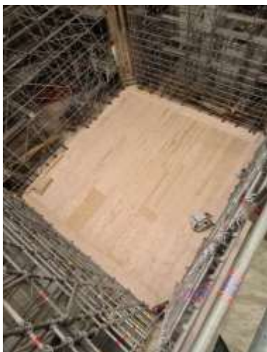
Visuel 8 Fin de la pose de la raquette en bois, plancher de répartition des charges sur lequel prendra appui l'échafaudage nécessaire à la reconstruction de la flèche. © Etablissement public chargé de la conservation et de la restauration de la cathédrale Notre-Dame de Paris
