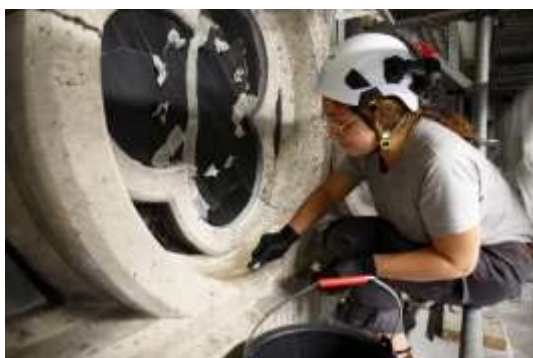
Visuel 1 Nettoyage des maçonneries. © David Bordes / Etablissement public chargé de la conservation et de la restauration de la cathédrale Notre-Dame de Paris
