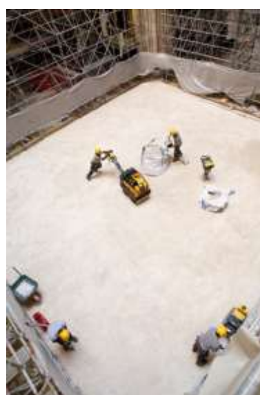
Visuel 4 Le sol à la croisée du transept en train d'être comblé par de la grave compactée. © David Bordes / Etablissement public chargé de la conservation et de la restauration de la cathédrale Notre-Dame de Paris
