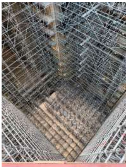
Visuel 10 Pose des premiers éléments de l'échafaudage nécessaire à la reconstruction de la flèche. © Albane Gauvain / Etablissement public chargé de la conservation et de la restauration de la cathédrale Notre-Dame de Paris
