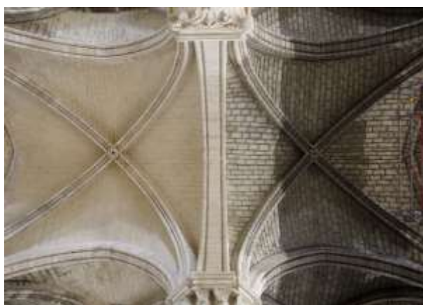
Visuel 8 Les voûtes des collatéraux après et avant leur dépoussiérage. © David Bordes / Etablissement public chargé de la conservation et de la restauration de la cathédrale Notre-Dame de Paris
