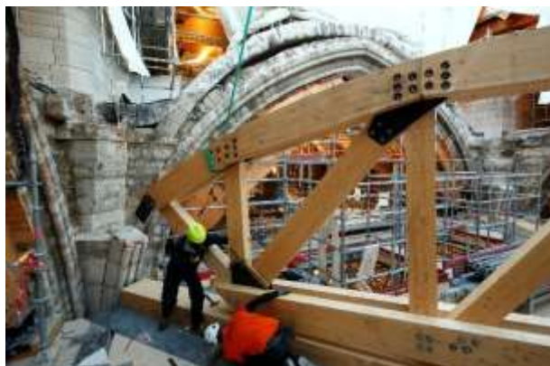
Visuel 18 Pose des cintres qui serviront à reconstruire les arcs de la voûte à la croisée du transept. © David Bordes - Etablissement public chargé de la conservation et de la restauration de la cathédrale Notre-Dame de Paris
