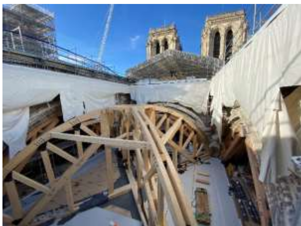
Visuel 22 Les cintres qui serviront à reconstruire les arcs de la voûte à la croisée du transept sont posés. © Etablissement public chargé de la conservation et de la restauration de la cathédrale Notre-Dame de Paris
