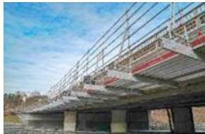
**FlexBeam** : Conçue pour répondre aux contraintes spécifiques des ouvrages d'art, la plateforme suspendue FlexBeam de Layher permet de réduire significativement les délais d'intervention lors des opérations de rénovation et de maintenance. Basée sur l'échafaudage Universel® Layher, FlexBeam intègre une poutre en aluminium nouvelle génération, à la fois légère et haute résistance, facilitant la manutention et accélérant le montage.
