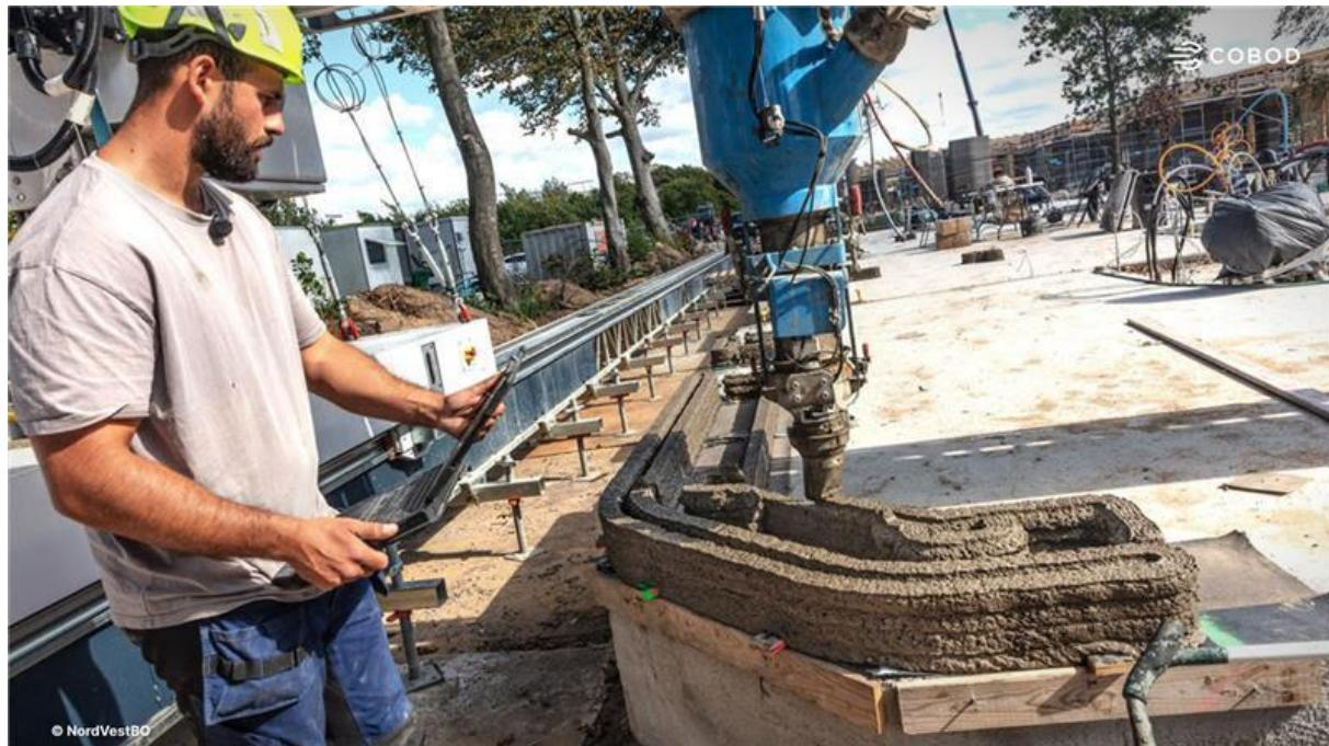
3DCP Group pilote l'imprimante COBOD BOD3 sur le chantier. Le système de rails au sol de la BOD3 permet une impression continue de longues sections de murs, garantissant des résultats constants avec une équipe de trois personnes.
