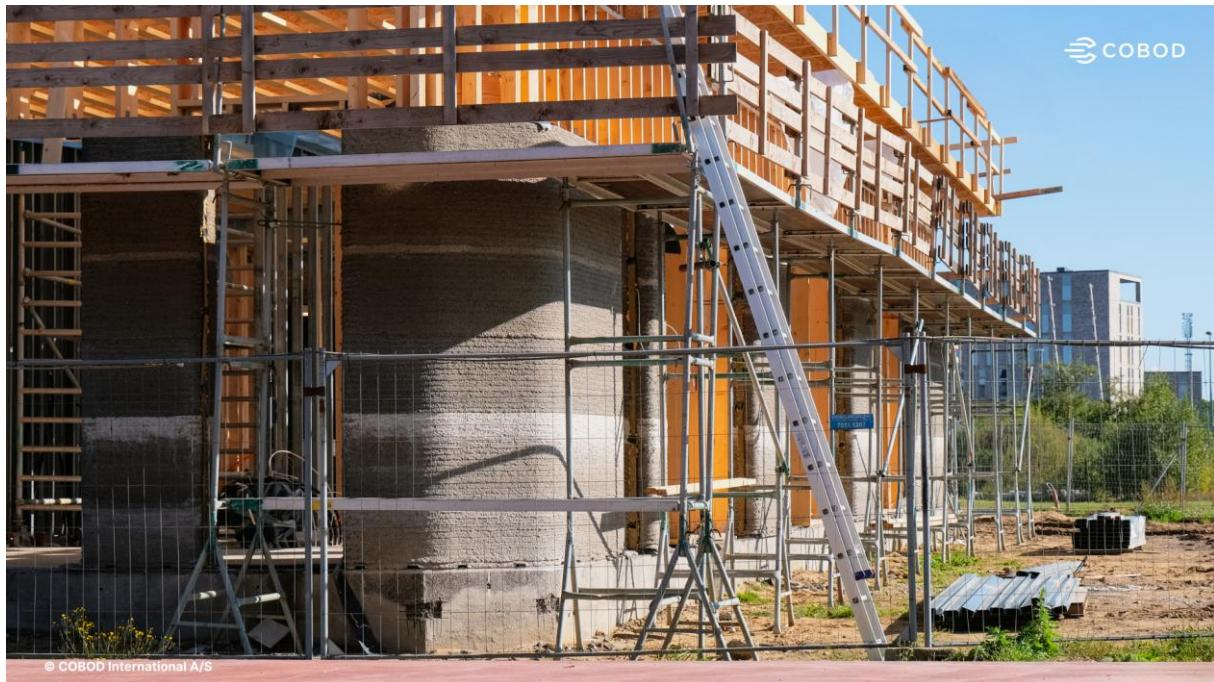
Murs imprimés en 3D associés à des structures bois pour former des logements étudiants modernes et durables. Le projet illustre l'intégration de l'impression 3D avec des méthodes de construction conventionnelles.
