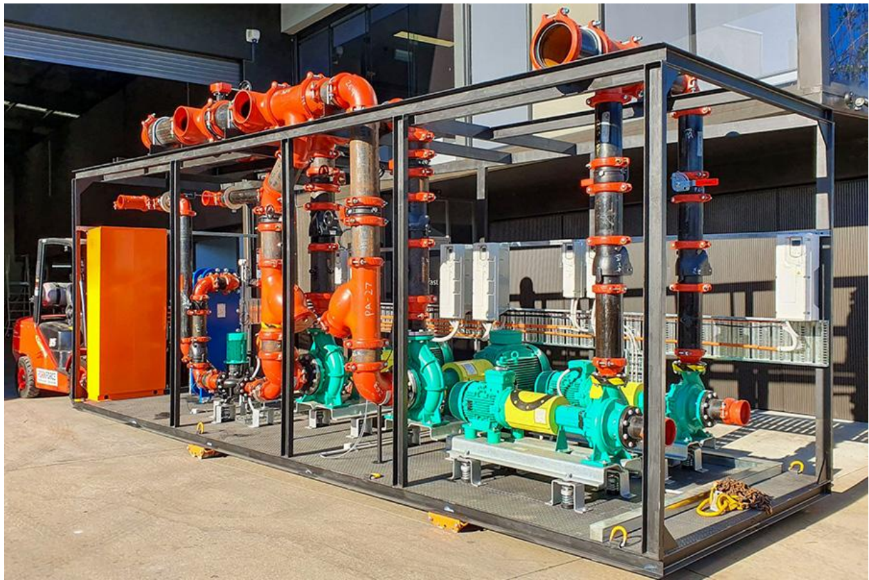
La préfabrication permet une installation rapide et sans risque, ce qui réduit les besoins en main-d'œuvre et les coûts.
