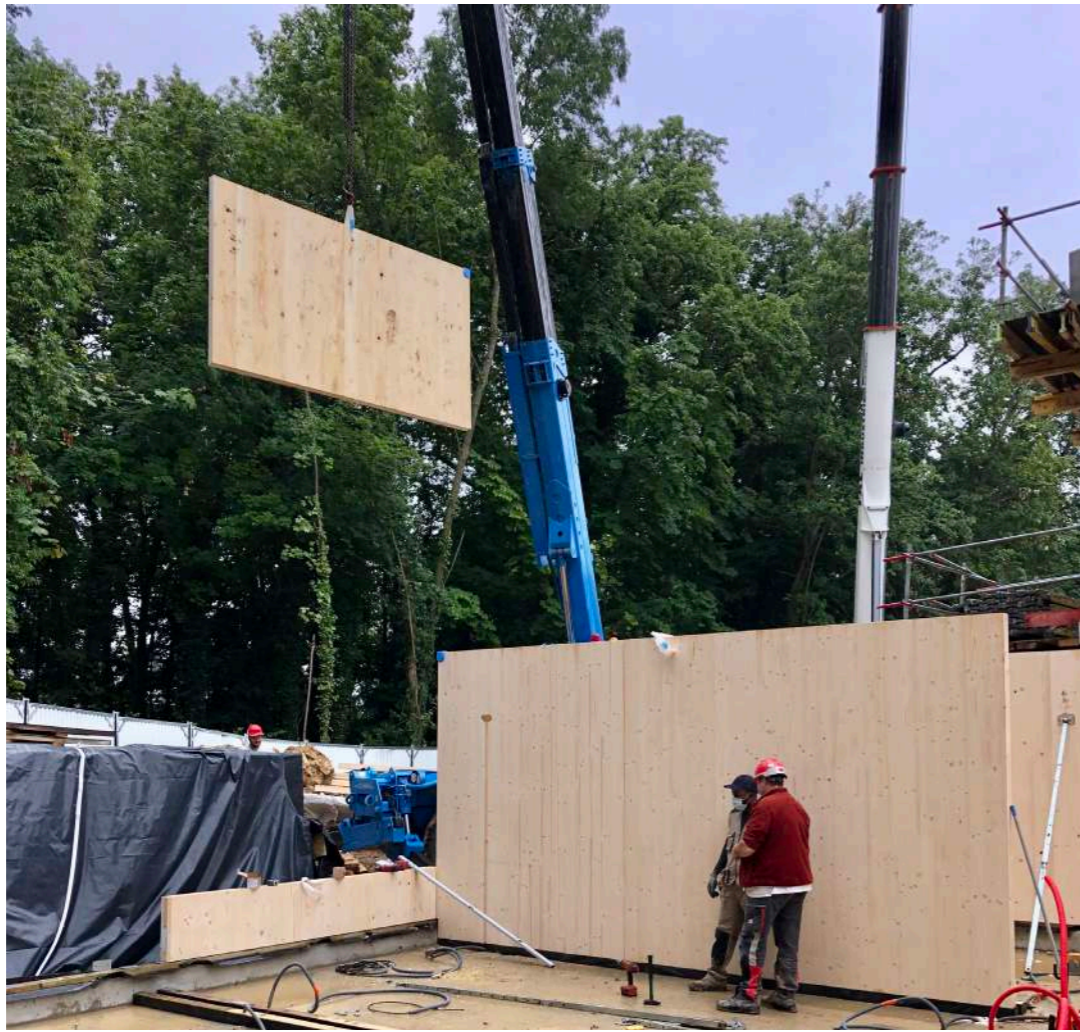
Photo de chantier
