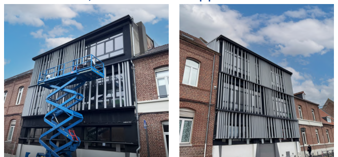
Institution Ste Famille St Christophe à Béthune (62) - SF à 15° en pose verticale lames debout Architecte : Stragimmo Pose : CMCI
