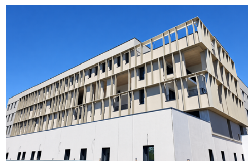
Brise-soleil en Quadrille au Centre Hospitalier de Pau - Copyright MAB65
