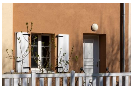
Résidence OPAC de l'Oise à Pont Sainte-Maxence (60) Crédit photo : Manuel Panaget
