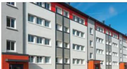
Logements sociaux, boulevard des Arcades, Limoges (87)
