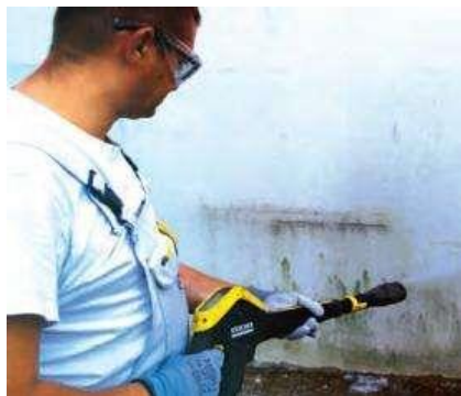
Travaux de décontamination
