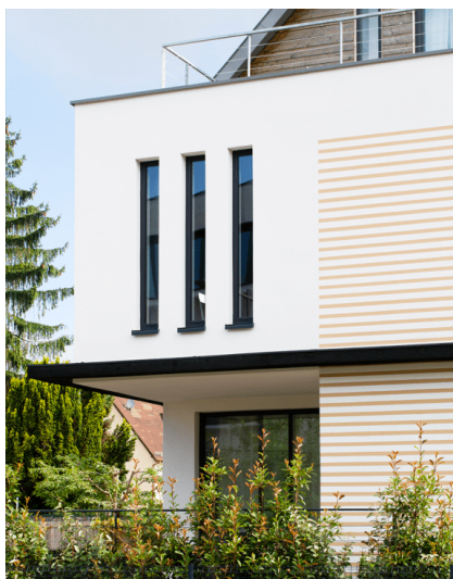
Dans le cadre d'une remise en peinture, certains revêtements de façade sont à privilégier. Exemple ici d'une rénovation réalisée avec l'enduit autonettoyant StoLotusan® et la peinture StoColor Lotusan® pour les lignes horizontales. Crédit photo : Simeon Levailant
