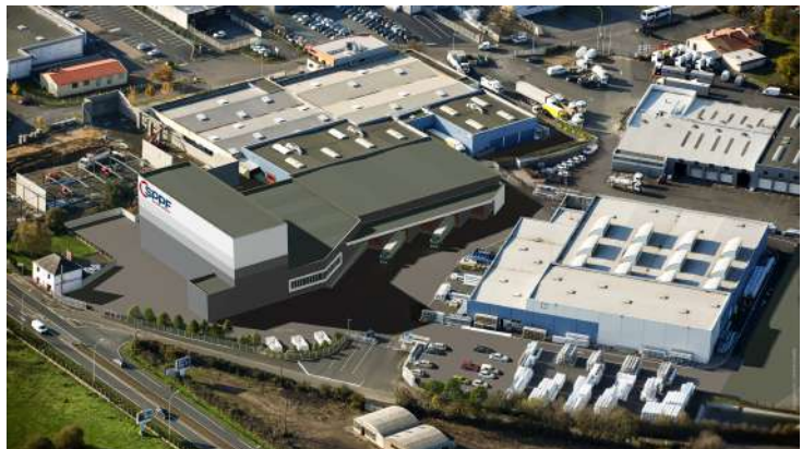
Site SPPF avec les deux nouveaux bâtiments
