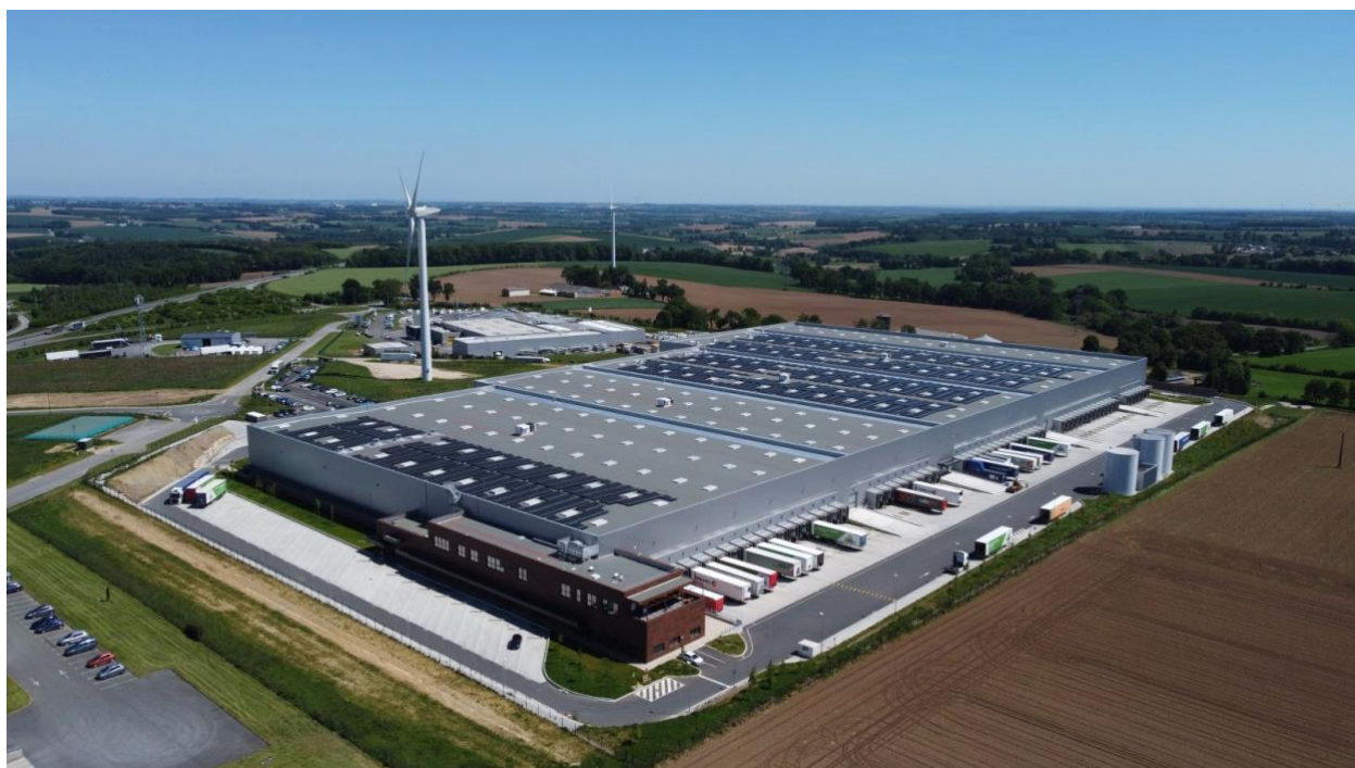
Toiture solaire photovoltaïque Solstyce sur une plateforme logistique, Zone d'activités de Bel Air à Saint-Caradec (22).
