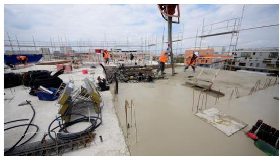
Sur les 22 000 m<sup>3</sup> de béton utilisés pour ce projet, l'entreprise **EQIOM** a utilisé **80% de béton bas carbone, permettant une réduction de 40% de l'impact carbone** en comparaison avec un béton classique. L'îlot fertile est donc résolument précurseur dans sa conception, et vaut la **remise du prix « bas carbone » du concours au groupe EQIOM.**
