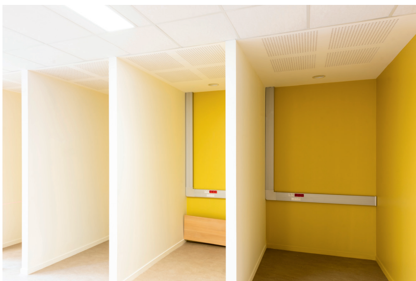
Plafond avec plaque de plâtre acoustiques perforées CREASON C10 n°8
