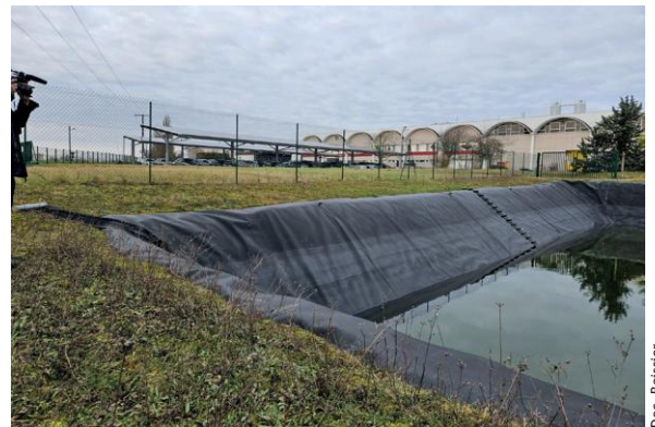
Le bassin de rétention des eaux pluviales équipé de rampes d'évacuation pour les grenouilles.
