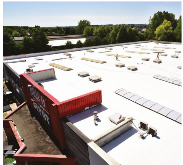
Cool Roofing, revêtement thermo-réactif, du toit du dépôt de Saumur.
