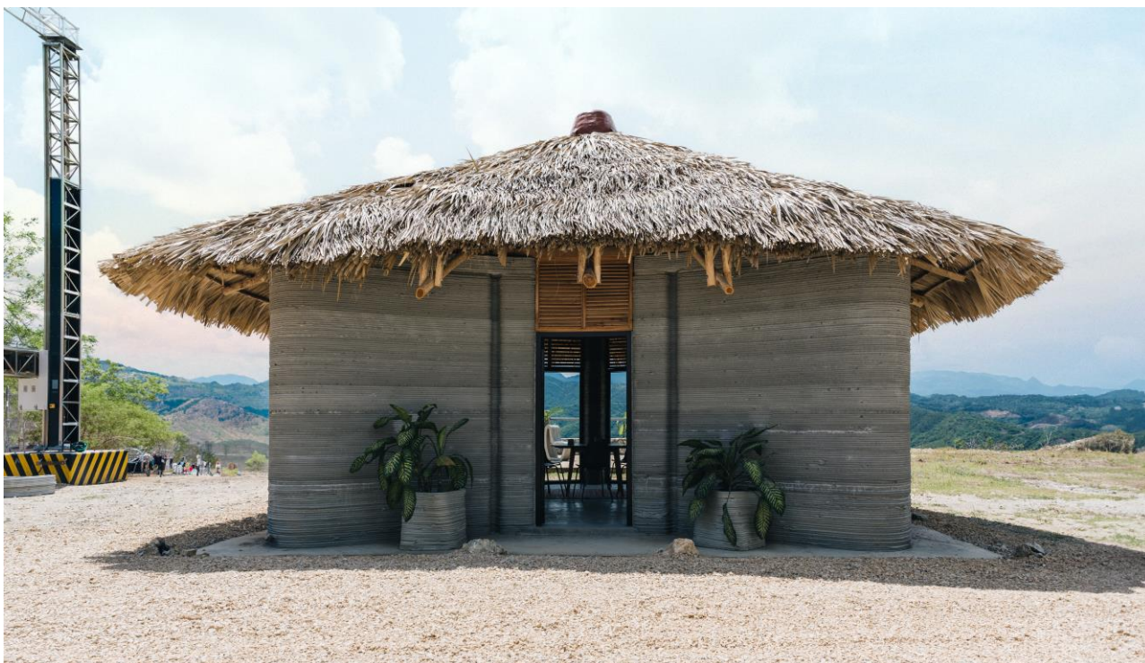
L'entrée de la première maison imprimée en 3D au Guatemala.
