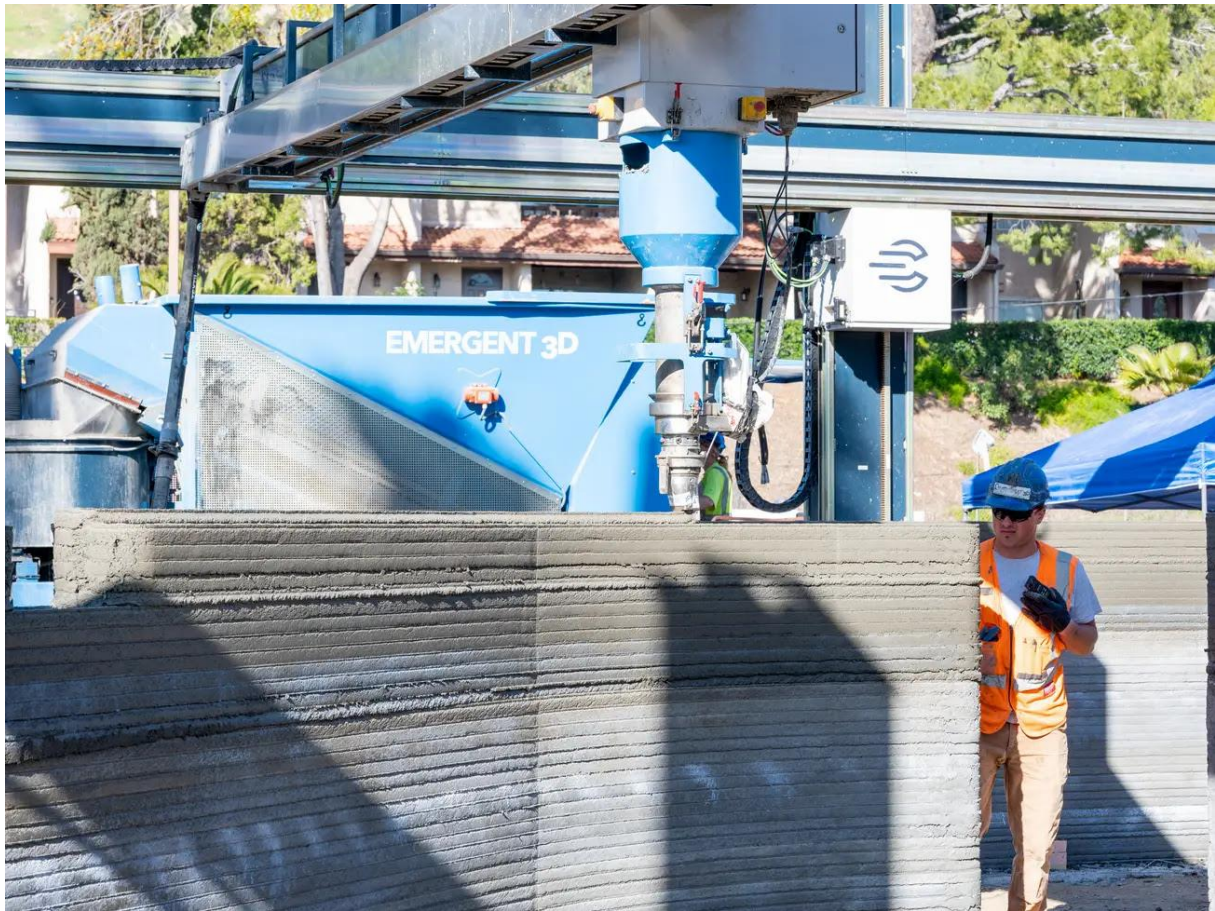
Solar Futures House, construite avec l'imprimante 3D de construction BOD2 de COBOD, est sortie en un temps record de 15 heures d'impression.
