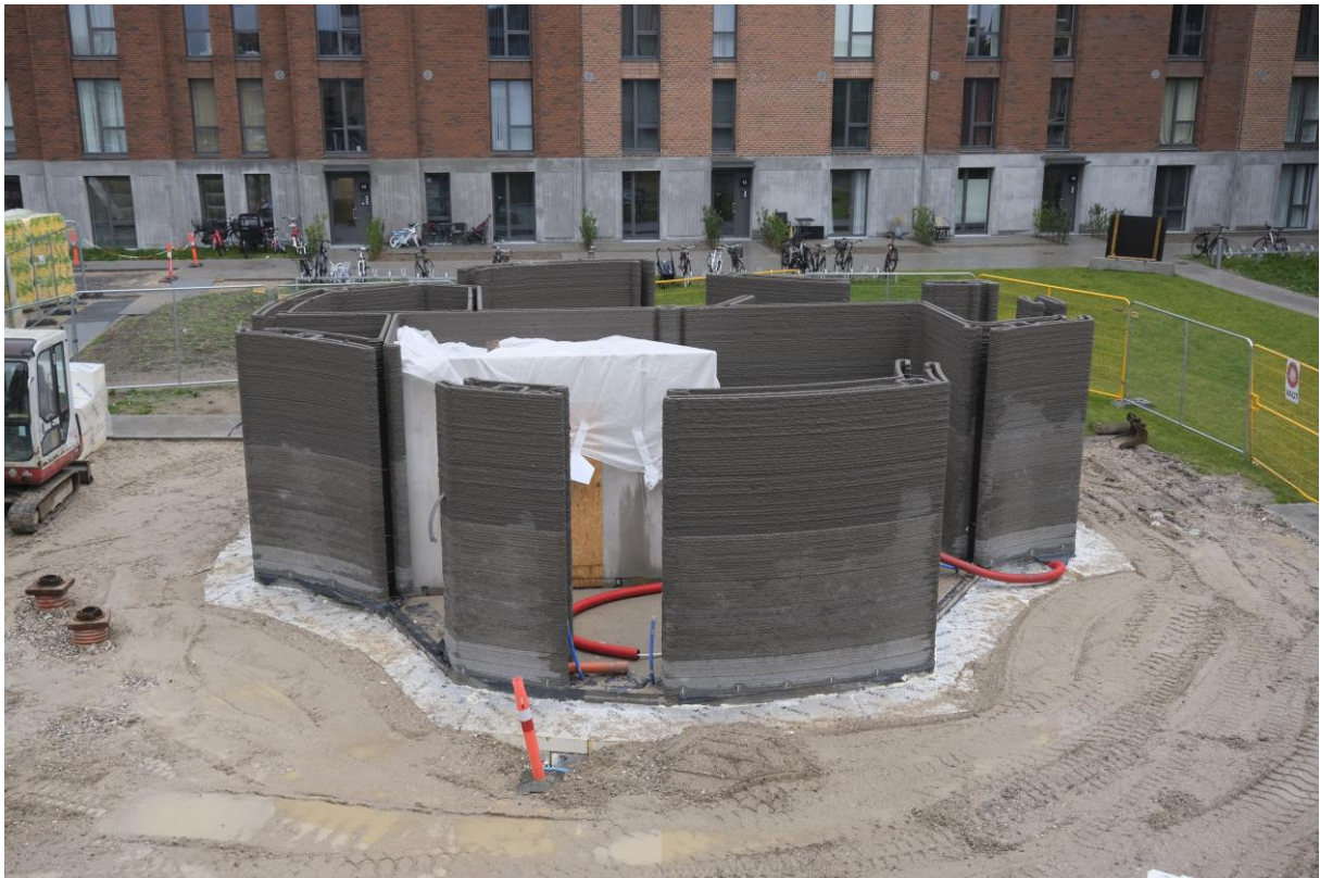
Premier bâtiment en béton à faible taux de CO2 imprimé en 3D à Copenhague - un bâtiment communautaire de 72 m2.
