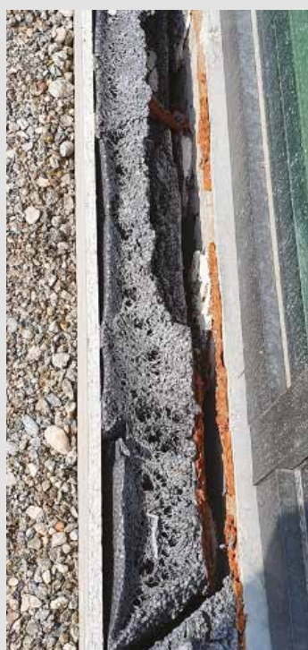
Isolant dégradé par le rayonnement solaire
