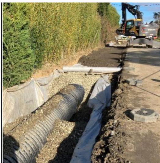
Conçus à partir de polythène haute densité 100 % recyclé, provenant exclusivement de la collecte sélective, et entièrement recyclables, [les drains ECODREN de Polieco](#) sont particulièrement adaptés au drainage des eaux pluviales dans les réseaux civils, routiers et ferroviaires, ainsi qu'aux systèmes d'infiltration. Dans le cadre de l'aménagement de la piste cyclable, le fossé le long de la route a été équipé de drains conformément aux spécifications suivantes :
