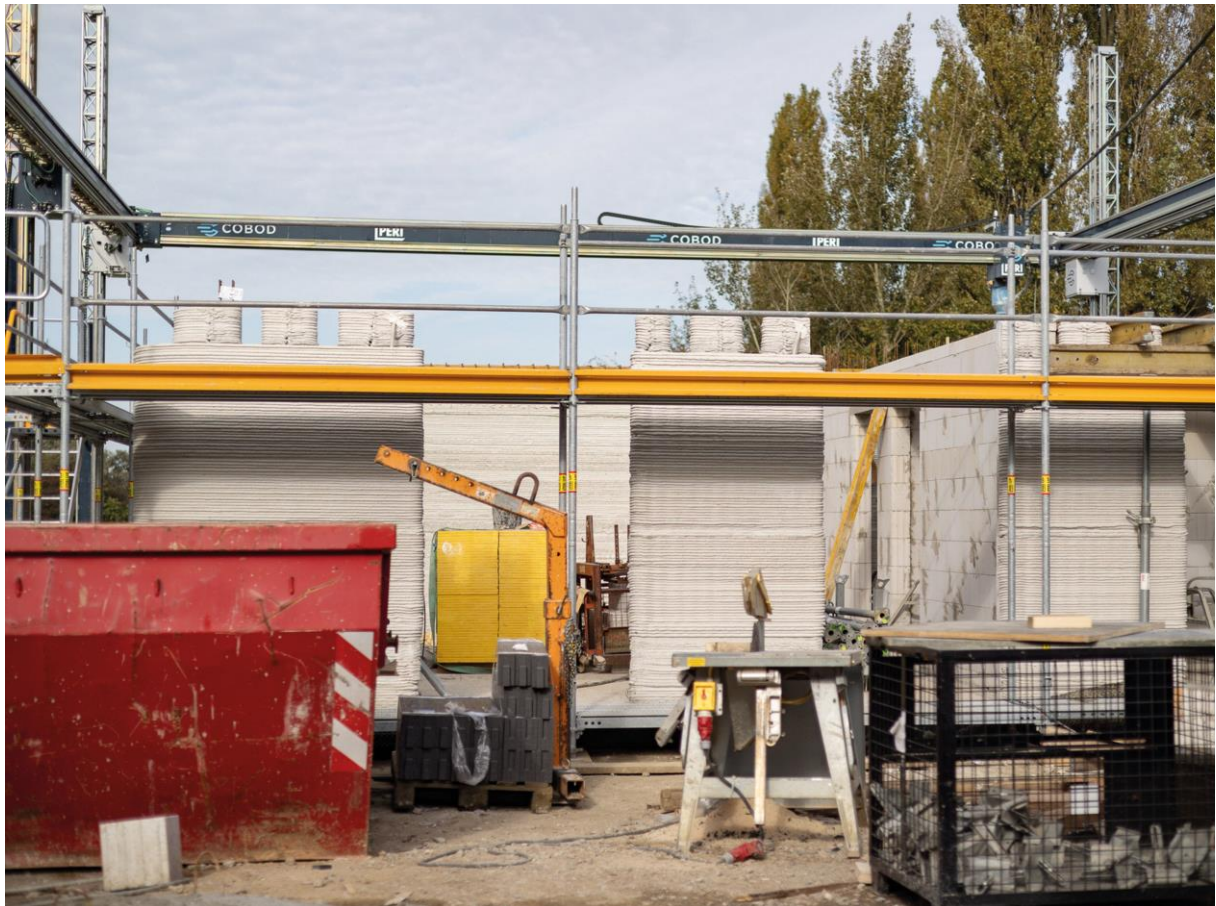
PERI 3D Construction en Alemania utiliza la impresora de construcción 3D de COBOD para la primera vivienda plurifamiliar financiada con fondos públicos
