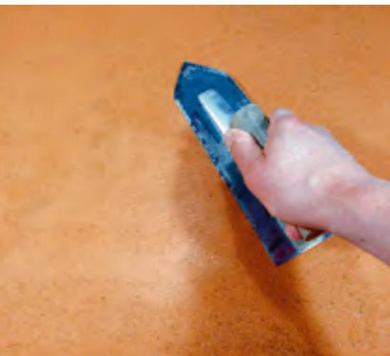
*Le lissage de l'enduit de finition, après le talochage, permet d'enfoncer les grains de sable.*
