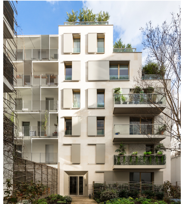
NOVA SLIDE, immeuble de logements rue de la Pompe, Paris 76016. Crédit photo : NOVAL
