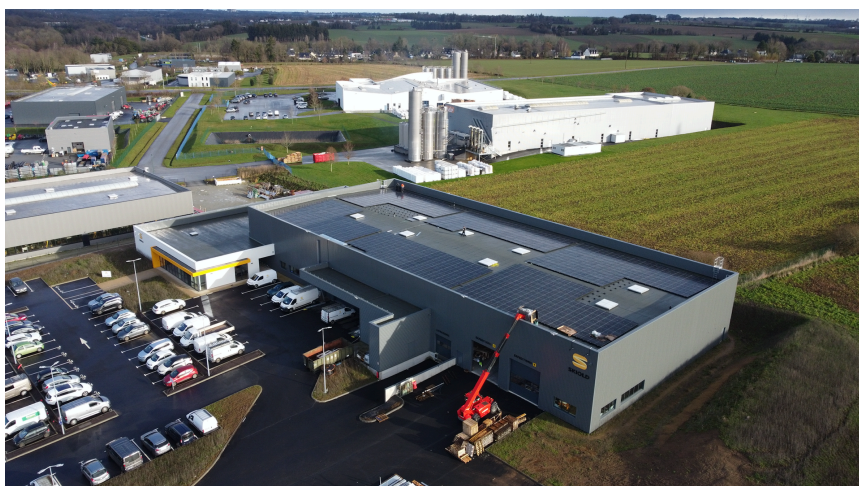
Chantier BARDON Solar – Bâtiment de la Société SKIOLD à Pontivy (56)
