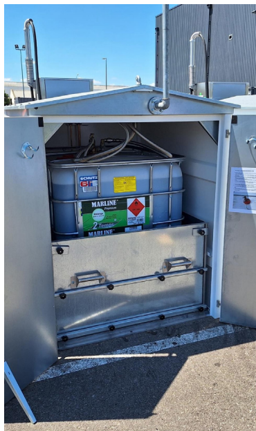
Cuve IBC sur palette pour un remplacement facilité
