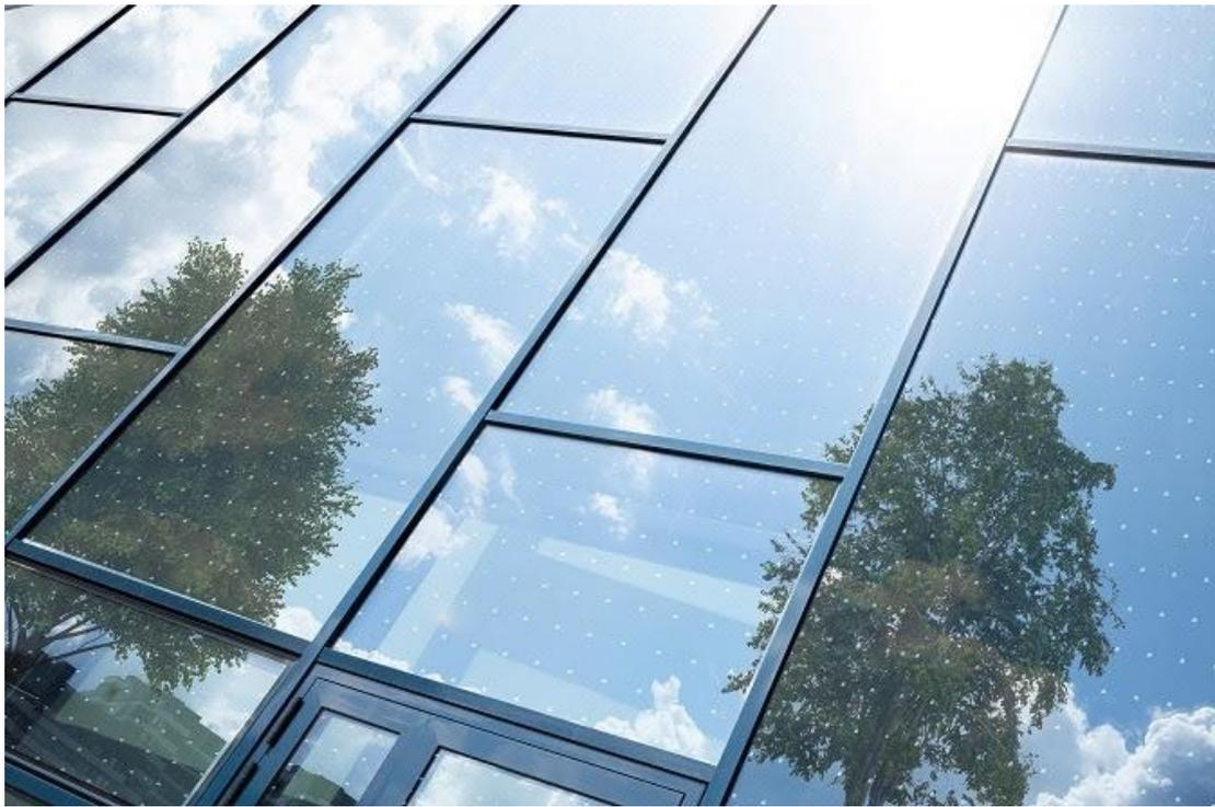
*Les intercalaires Saflex® FlySafe™ 3D PVB, une solution hautement efficace visant à empêcher les oiseaux de heurter les surfaces vitrées, sans compromettre l'esthétique et la vision. Image Eastman, tous droits réservés.*
