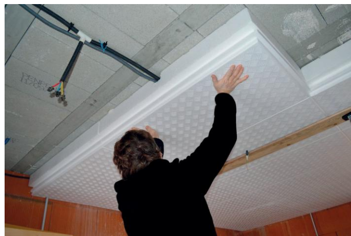
Mise en œuvre de DECOBOX 36
