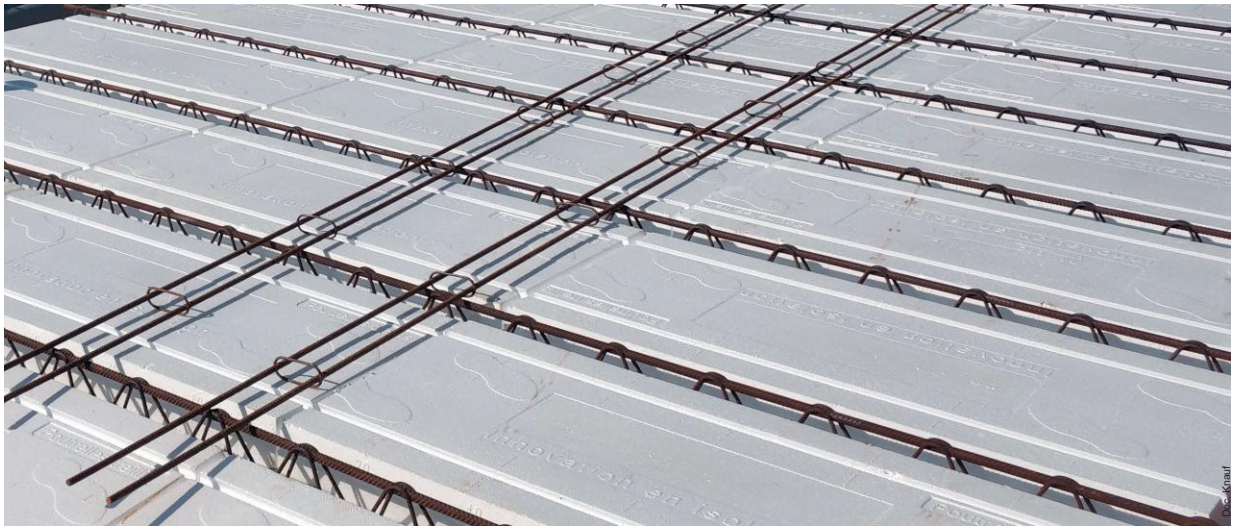
Mise en œuvre de COFFRABOX PT
