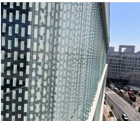
Brise-soleil vitré en façade - bureaux VINCI à Nanterre (92)
