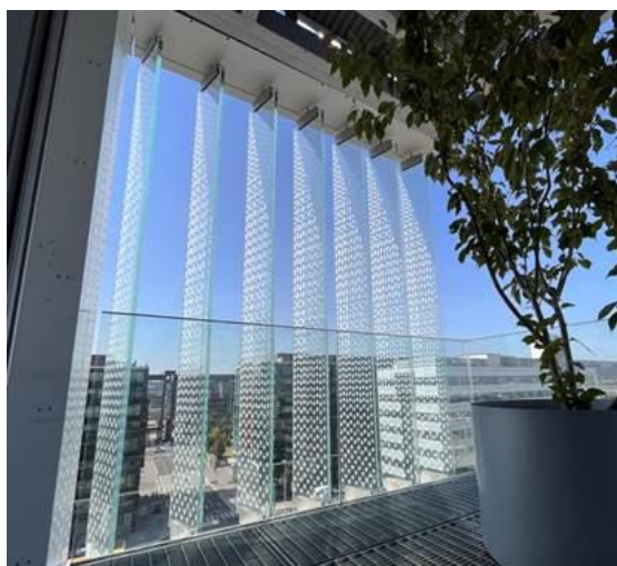
Brise-soleil vitré en façade - bureaux VINCI à Nanterre (92)
