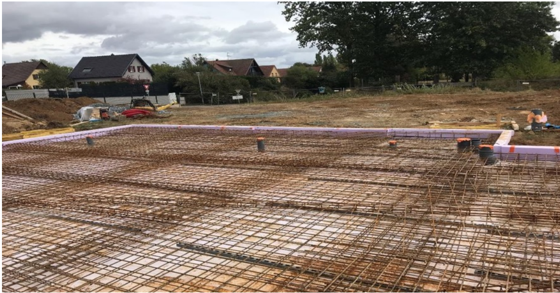
Avant coulage du radier béton.
