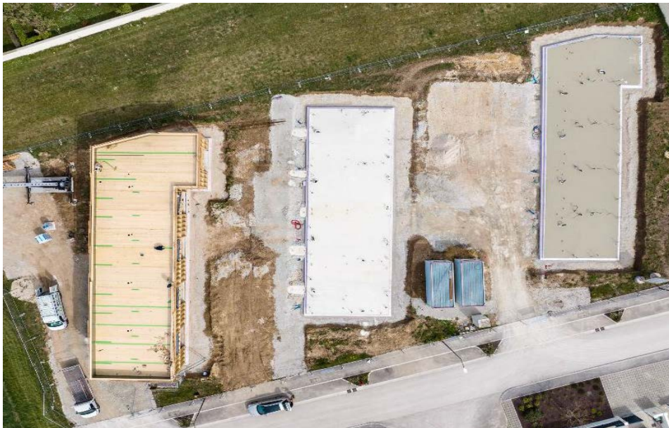
Les 3 bâtiments à différents stades de finition.
