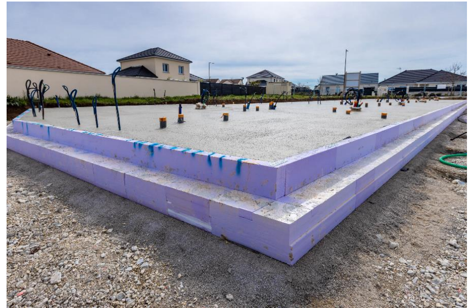
Le planning chantier a été respecté.
