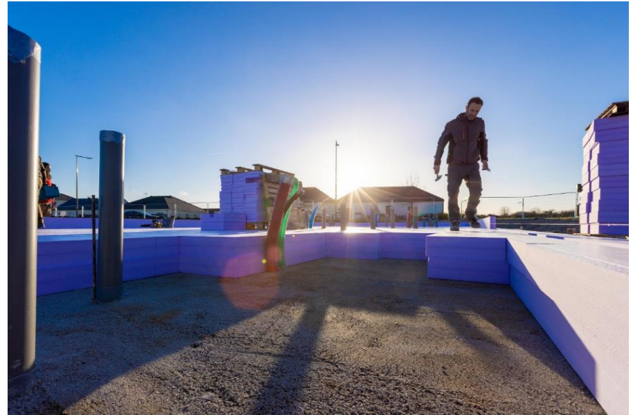
Les éléments de surface se posent aisément grâce aux feuillures alternées.
