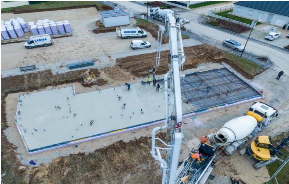
Coulage du radier béton de 250 mm d'épaisseur.
