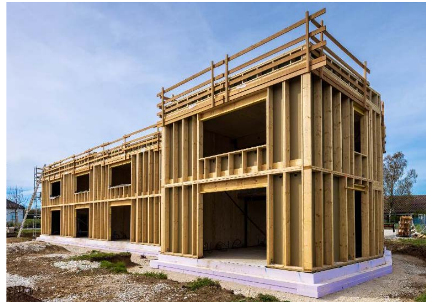
L'ossature bois pour l'enveloppe extérieure du premier bâtiment est terminée.
