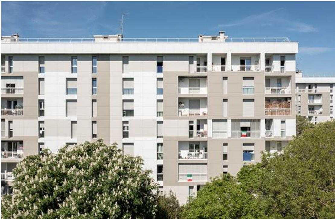
Prenons par exemple ses panneaux Hardie® Panel. Leur composition en fibres-ciment de moyenne densité (11,2kg/m<sup>2</sup>) couplée à une optimisation de sa production lui permettent d'obtenir le bilan carbone le plus bas du marché comparé aux panneaux concurrents classés A2 en réaction au feu (Source Inies.fr décembre 2023, le bilan carbone des panneaux Hardie® Panel est de 12,3 Kg/CO<sub>2</sub>, tandis que celui des panneaux A2 concurrents se situent entre 17 à 42,6 Kg/CO<sub>2</sub>).
