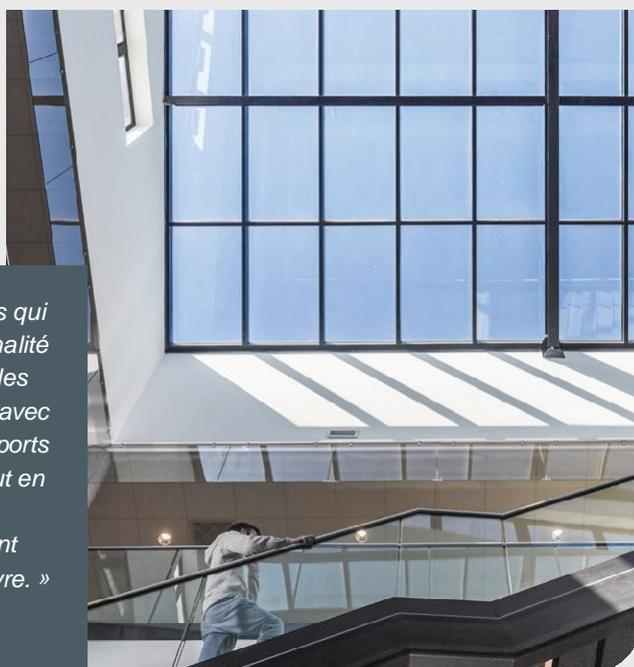
Le mur rideau, d'une longueur de 9 mètres et d'une hauteur de 2,30 m à 4 m, comprend 233 châssis au total. Installé en mode percutant, il a facilité l'installation tout en assurant des performances thermiques et acoustiques optimales. Cette solution a été associée à un bardage Lite Point de Saint-Gobain, avec des BSO et un remplissage
