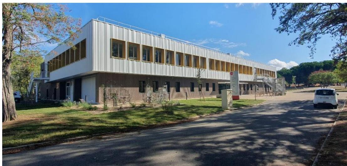
Ce projet a fait l'objet d'une rénovation énergétique par une isolation thermique par l'extérieur complète (parois verticales et toiture, menuiseries) et d'une restructuration intérieure partielle pour la création de bureaux.
