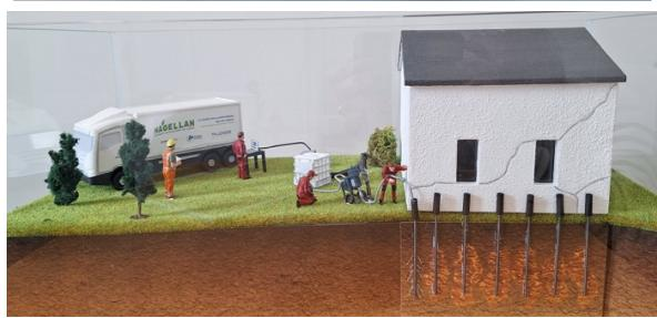
La technologie MAGELLAN® repose sur l'imprégnation des sols porteurs par une solution riche en silice. En gélifiant, elle crée de nouvelles liaisons moléculaires entre les argiles, ce qui les rend moins sensibles aux variations hydriques.
