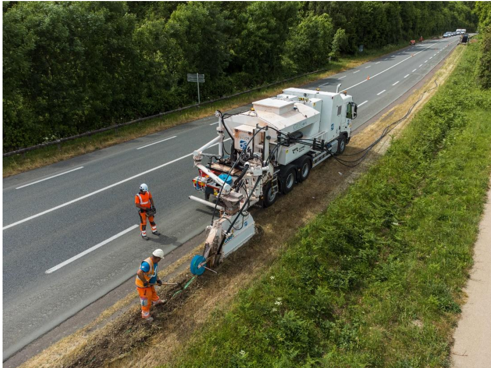
Application de la solution Greenpose par les équipes d'O.T.E
