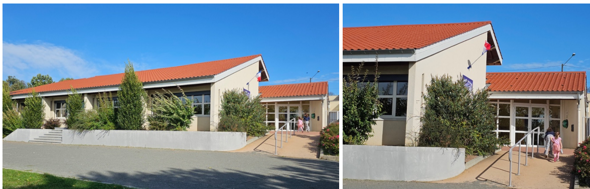
La salle des fêtes à Cuzieu (42) a reçu une nouvelle toiture en terre cuite, très résistante à la grêle. (Photos : Erlus)
