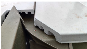
Bords de coupe soigneusement retouchés avec de l'engobe à froid. Photo : ERLUS, Thomas Eisele
