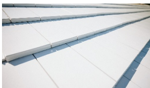
Détail de la tuile Level RS Cool Roof avec son système de triple emboîtement. Photo : Holzbau Aumann, Photographe Tobias Atzkern.
