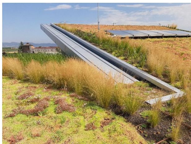
Crédit photo Bodegas Beronia - ZinCo GmbH
