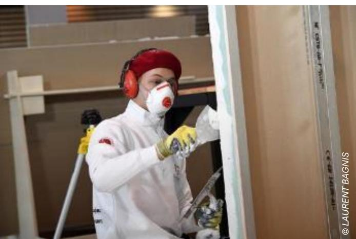
**LE METIER** - La **plâtrerie et construction sèche** comprend l'aménagement, la finition et la décoration des bâtiments par l'utilisation d'éléments et de matériaux principalement à base de plâtre. Le plâtrier est amené à la réalisation d'ouvrages en plaques de plâtre cartonnées, y compris la mise en œuvre des systèmes d'isolation, la pose de décors et de moulures préfabriquées à base de plâtre et l'application d'enduits intérieurs.
