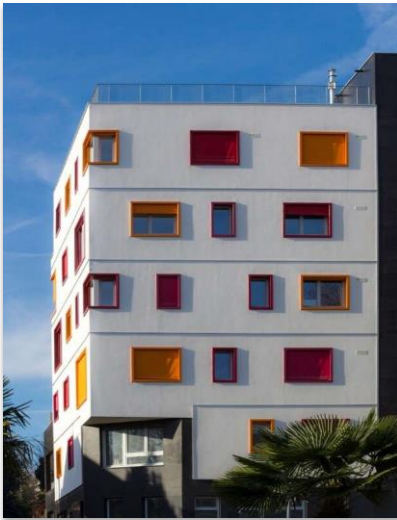
Logements / commerces à Montreuil (93) Solution Sto : StoVentec R Enduits sur COB en R+5 - Finition : Stolit K1 Architecte : Agence Meandre Maîtres d'ouvrage : CPA-CPS et ATHENAE CONSEIL Photo : @Manuel Panaget
