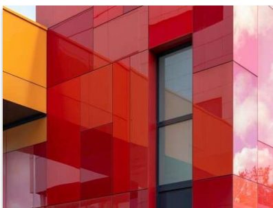
Poste de sécurité CHI André Grégoire, Montreuil (93) Solutions Sto : StoVentec Glass sur CLT Maître d'ouvrage : Centre Hospitalier Intercommunal André Grégoire Architecte : SCP Truelle Architectes Photo : @Manuel Panaget
