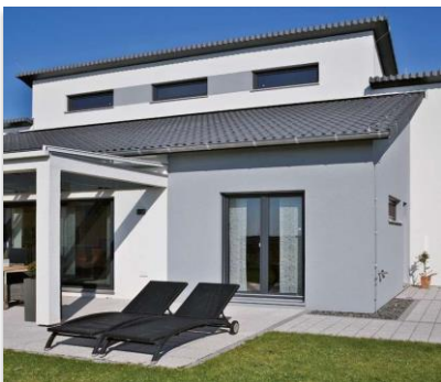
Pavillon neuf en conception préfabriquée, à Untersiema (Allemagne) Solution Sto : StoTherm Wood
