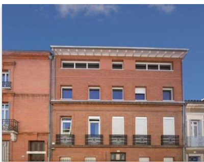
Extension en COB d'un immeuble collectif ancien classé à Toulouse Solution Sto : briquettes de parement sur StoTherm Classic® sur COB Architecte : Silvée Architecture Photo : @Sto - Silvée Architecture
