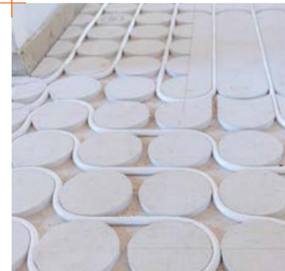
gypse fraisés en usine afin de créer des rainures ou des plots, de façon à pouvoir y loger les tubes de chauffage et obtenir une répartition homogène et optimale de la chaleur. Le procédé combine à la fois un ouvrage de chape sèche performant et un système de chauffage au sol tout aussi performant, offrant une solution innovante 2-en-1.
