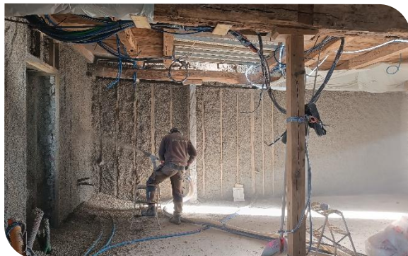
Le béton de chanvre en rénovation
