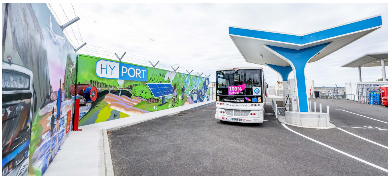
▶ 1 ère station d'Europe de production et de distribution d'hydrogène renouvelable en zone aéroportuaire - © Léo Arcangeli – Région Occitanie
