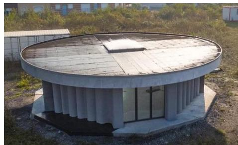
Après sa création en 2017, c'est en 2019 que Constructions-3D réalise le premier bâtiment imprimé en 3D : Le Pavillon. Il s'agit également de l'un des premiers ouvrages au monde à être intégralement imprimé avec un robot mobile : ce bâtiment d'une surface de 72 m<sup>2</sup> appelé « Le Pavillon » est sorti de terre en 24 heures.
