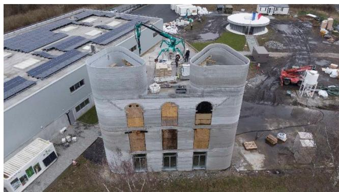
Dans ce cadre, La Tour est non seulement un exploit en termes de rapidité et de hauteur, mais représente surtout un modèle de durabilité et d'innovation. Ainsi, l'utilisation de l'impression 3D a permis de réduire considérablement les déchets de construction tout en optimisant les ressources et en réduisant l'empreinte carbone du projet : La Tour n'a pas nécessité l'utilisation de banches, ni de nacelles de coffrages et a permis l'intégration des châssis pendant l'impression.
