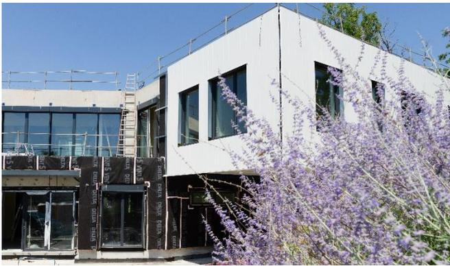
Si la pose « classique » du complexe global relève du cœur de métier de SOPREMA Entreprises, **le challenge essentiel de la mise en œuvre résidait dans l'application extérieure de l'isolant bois Pavatex®, une première pour SOPREMA Entreprises.** Techniquement, la difficulté était de faire face aux intempéries, pluie et vent, et de **garantir un isolant sec** avec un taux d'humidité respecté.
