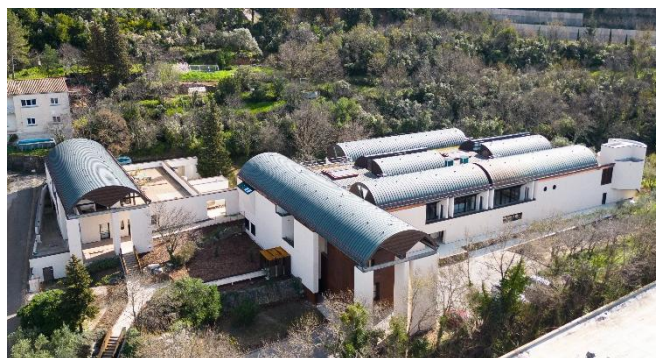
Crédit photo : SOPREMA Entreprises - Photographe Vincent ESCHMANN
