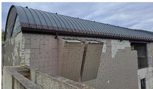
Avant travaux - Crédit photo : SOPREMA Entreprises
