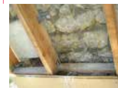
2-3. Pose des panneaux pare-pluie* et remplissage d'un conglomérat léger à base de roseaux.
