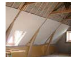
On peut également procéder par projection de cellulose humide. Dans ce cas la pose des plafonds doit n'être effectuée qu'après un parfait séchage de la matière. Doc. Entrepris S. Tinel, in La Maison écologique, n°51.
