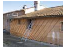
4. Pose des lattes support de bardage en diagonale pour améliorer le tirage thermique de la lame d'air (région très chaude en été).
